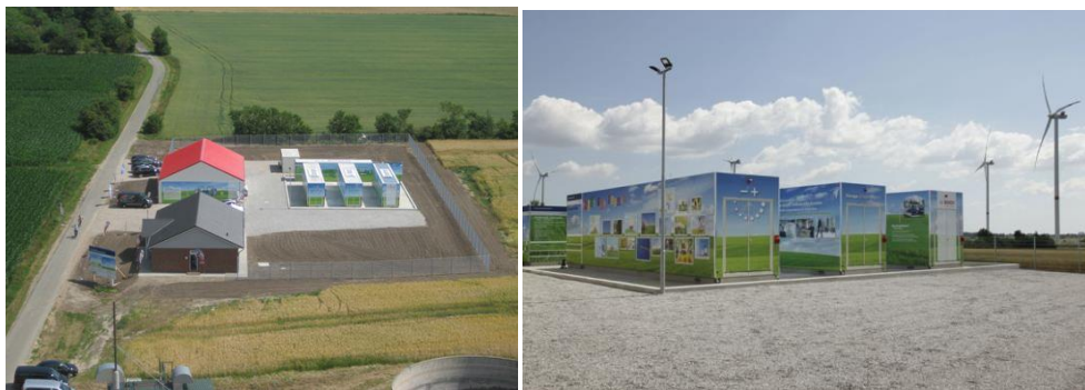
Abbildung 11: Windpark in Braderup – links in der Vogelperspektive und rechts die Energiespeicher; aus [e]
