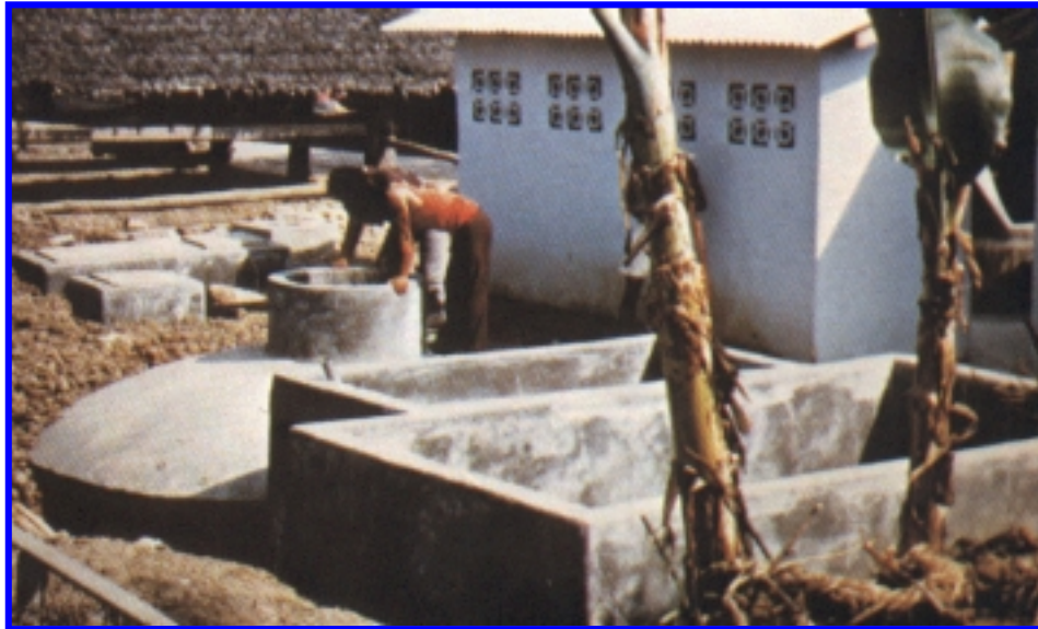
Bild 3.5 Die Entwicklung von Biogasanlagen chinesischen Typs bei BPPT mit einer Kapazität von 20 m 3
