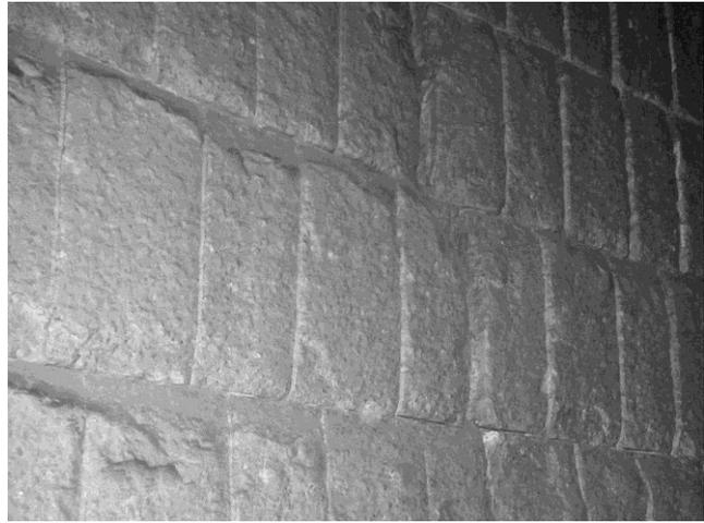
**Abb. 2.7.** Ausgewaschene Mauerwerksfugen in der Target-Area eines Zyklonabscheiders, Kessel 11 der Stadtwerke Flensburg (Aufnahme des Autors)
